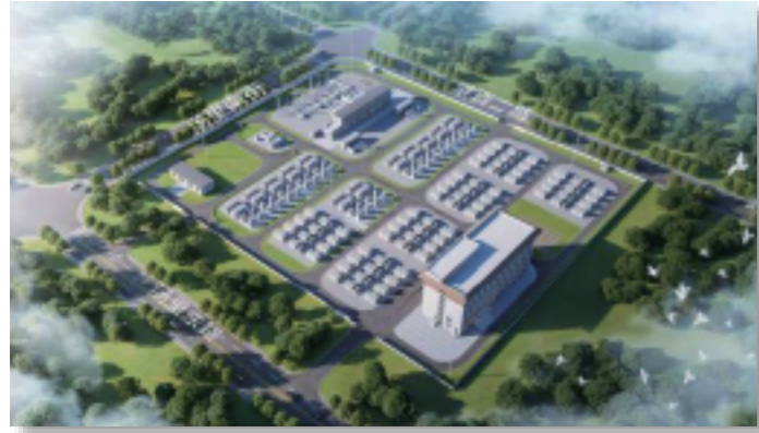
山西运城混合调频储能电站项目
