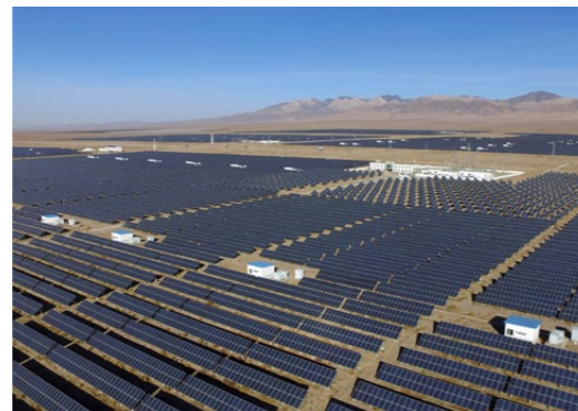
德令哈储能项目
